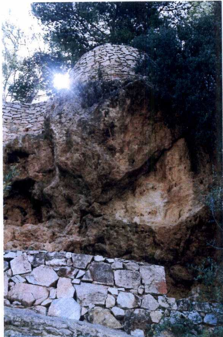
Fotografía 1.2. Detalle de los bloques inestables a sanear de la parte superior de la Zona 1. Bloques en parte sujetos por las raíces de los árboles a eliminar.
