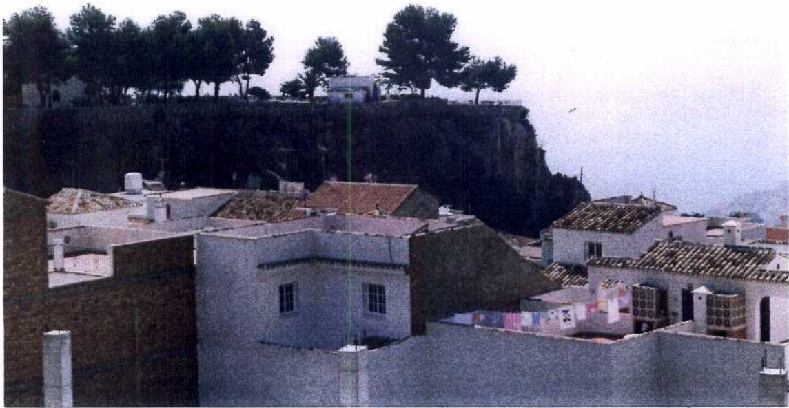
Fotografía 1. Vista general de la ladera W, escarpada y con un talud muy verticalizado.
