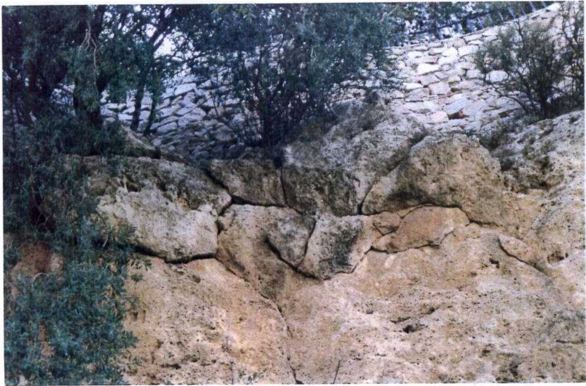
Fotografía 1.2. Detalle de los bloques inestables a sanear de la parte superior de la Zona 1. Bloques en parte sujetos por las raíces de los árboles a eliminar.
