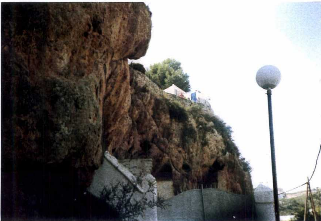
Fotografías 2.1. y 2.2. Vistas de la Zona 2, con las cavidades y socavaciones en la parte inferior del talud, que se han cercado con un muro y puertas. El aspecto del resto del talud es bastante sano, aunque agrietado, sin presencia de zonas blandas .
