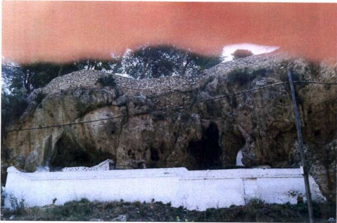
Fotografías 2.1. y 2.2. Vistas de la Zona 2, con las cavidades y socavaciones en la parte inferior del talud, que se han cercado con un muro y puertas. El aspecto del resto del talud es bastante sano, aunque agrietado, sin presencia de zonas blandas .
